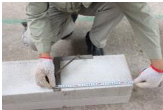
Hình 22: Đo, lấy dấu bằng thước và bằng cữ
