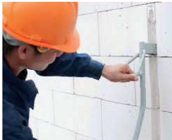
Hình 25: Cắt và tạo rãnh âm tường
