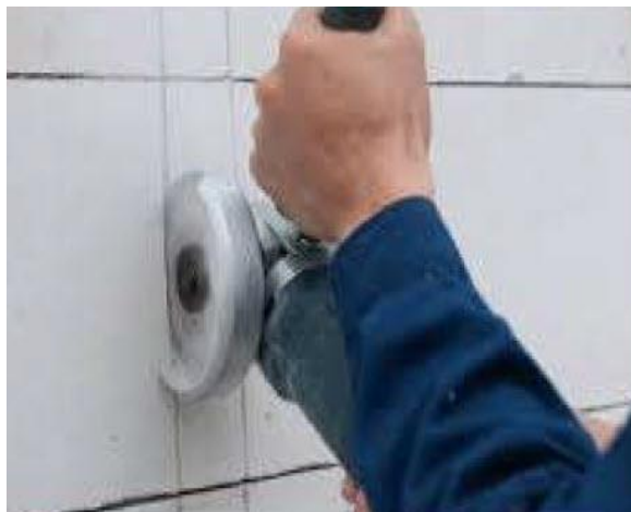
Hình 25: Cắt và tạo rãnh âm tường
