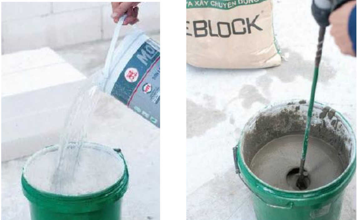
Hình 27: Trộn vữa xây, trát chuyên dụng
