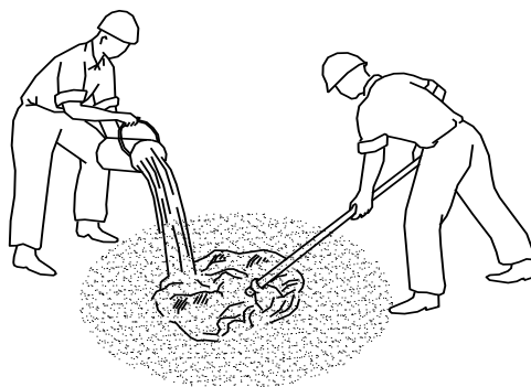
Hình 18: Trộn vữa thủ công
