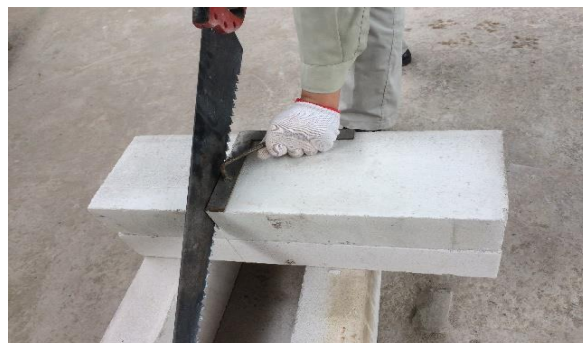
Hình 23: Cắt gạch AAC bằng cưa tay
