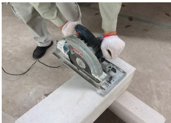
Hình 24: Cắt gạch AAC bằng máy
