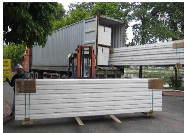
Hình 10: Tấm panel YTONG có kích thước lớn
