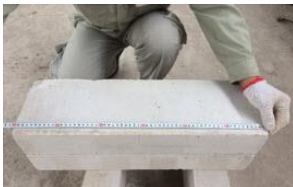
Hình 22: Đo, lấy dấu bằng thước và bằng cữ
